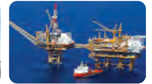
海洋平台管桩 Offshore platform pile
