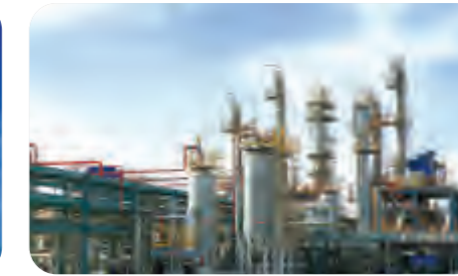
石油化工塔器 Petroleum chemical tower
